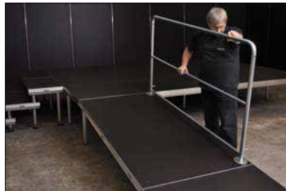
bei Bedarf Geländer einsetzen
