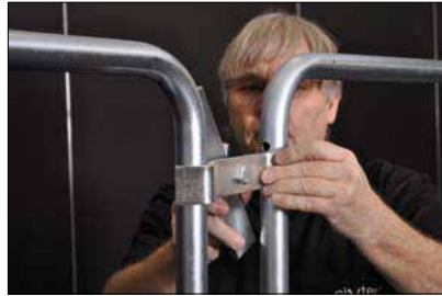
Geländer-Verbinder 150 mm einsetzen
