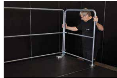
Seitengeländer einsetzen
