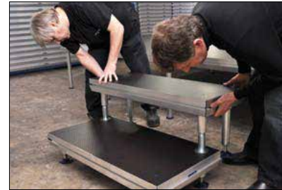
Stufen mit FüÙen bestücken, Treppe aufbauen letztes Stufenpodest: Tiefe 39 cm
