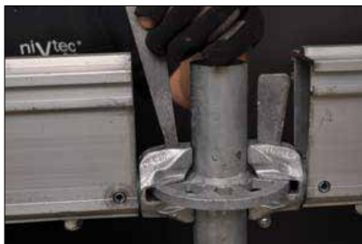
Keilkopf in Lochscheibe einstecken...
