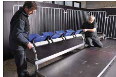
Sitzträger aufstecken und sichern
