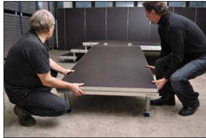
2 Füße einsetzen und Podest einhängen
