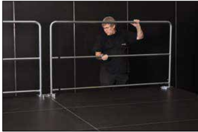
Bühnengeländer hinten aufstecken Sicherungsschrauben festziehen
