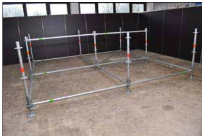
Gerüstkonstruktion nach Plan aufstellen
