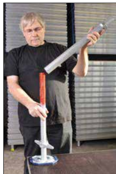
Wechselfuß auf Spindel aufstecken
