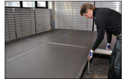
Feder in Nut einhängen
