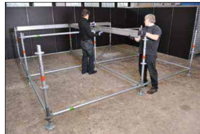
Lastenträger nach Plan einsetzen
