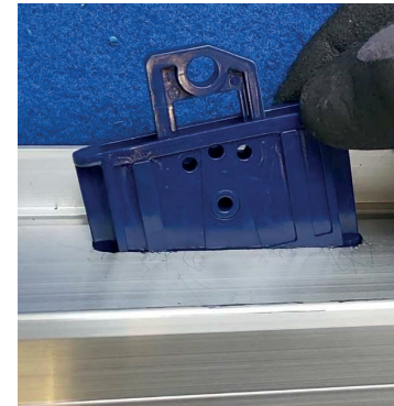
5. Neues Klick-Klack-Gehäuse in korrekter Position in das Langloch einschieben und mit einem Gummihammer im Wechsel links / rechts einschlagen.
