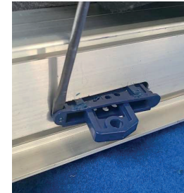
4. Gehäuse mittels Schraubendreher heraushebeln
